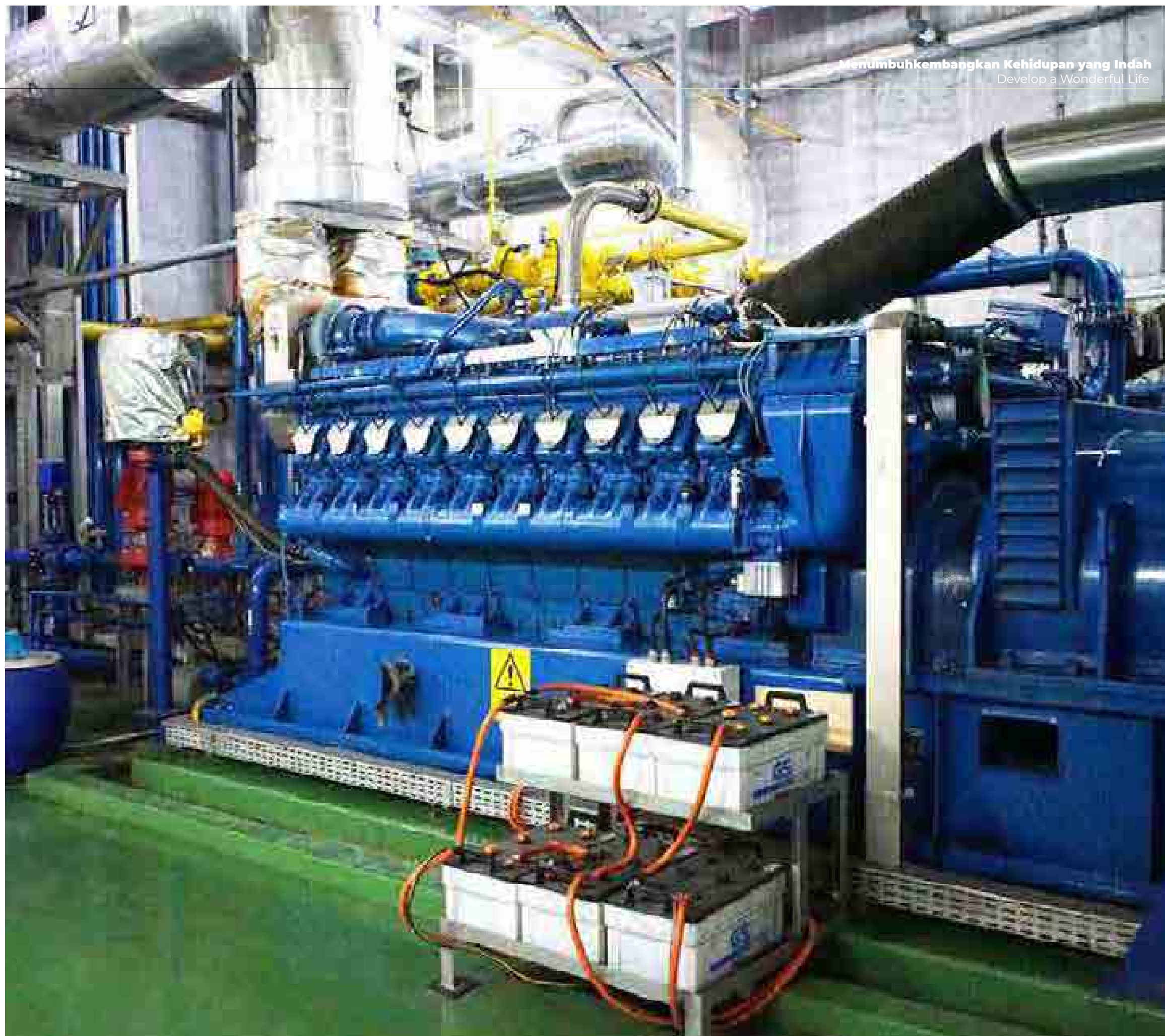
Gas Engine untuk Chiller Absorpsi
