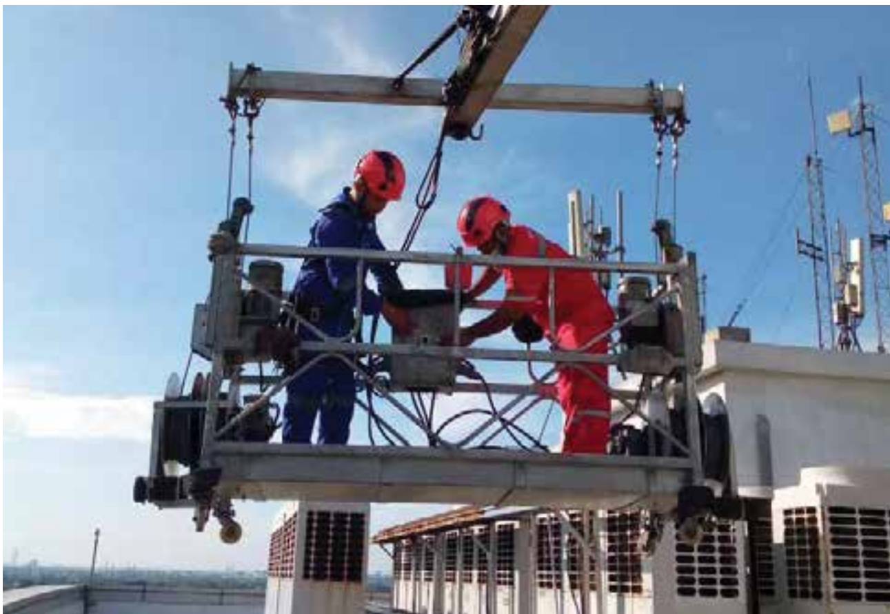
Prosedur Keselamatan Kerja Sebelum Operasional Gondola, Summarecon Serpong
