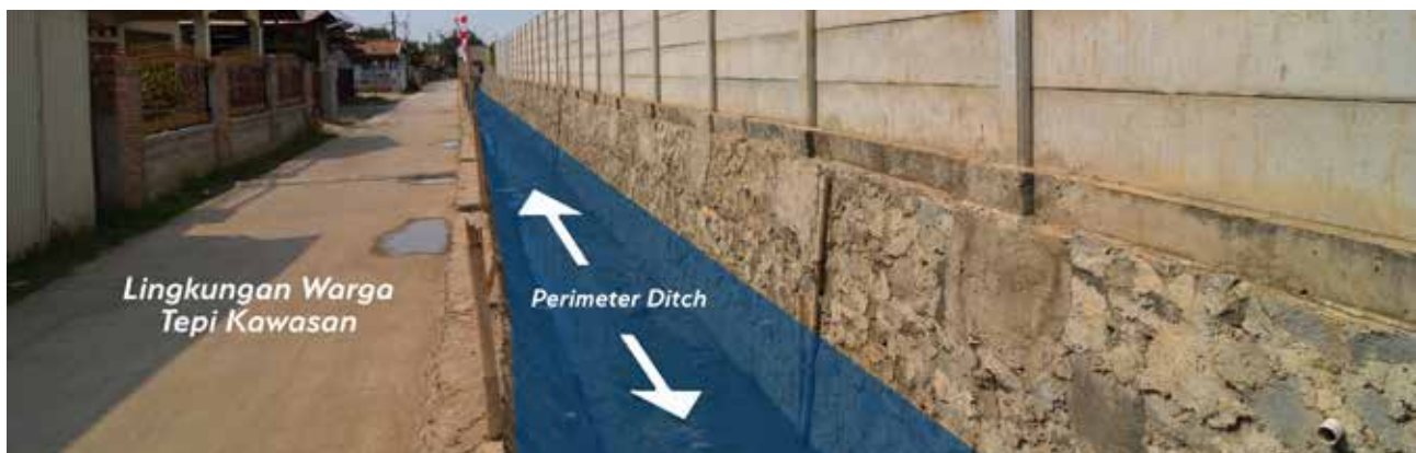
Perimeter Ditch, Summarecon Bekasi
