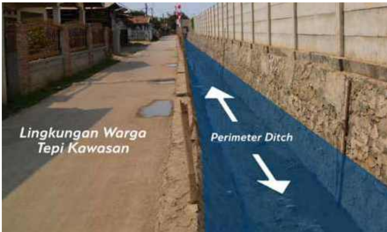
Perimeter Ditch, Summarecon Bekasi
